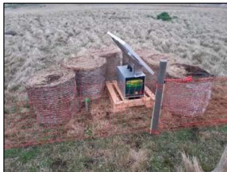
Photo 2 : Poste électrique de la clôture
