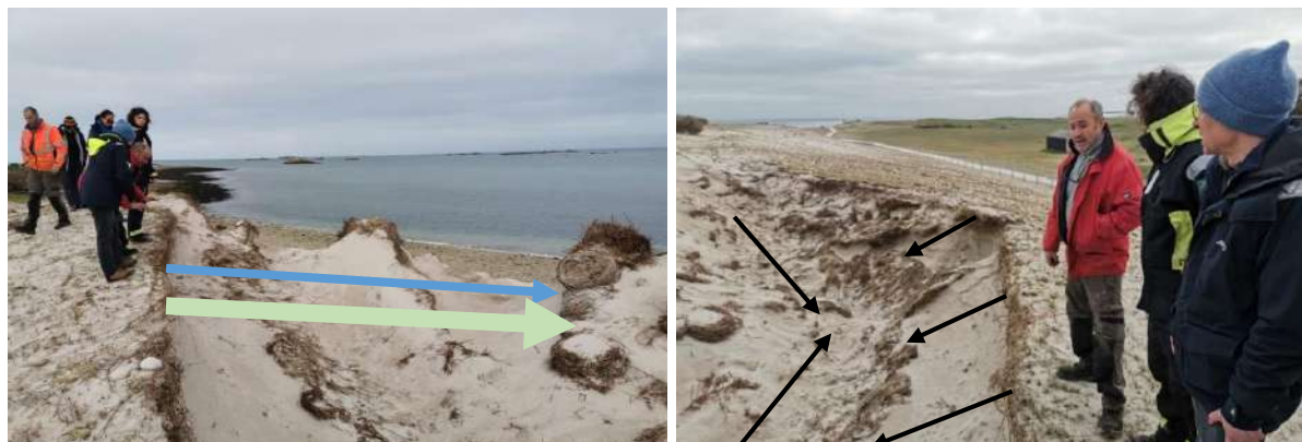
Figure 2: Stratégie de confortement d'une caoudeyre par positionnement de ganivelles et bottes de foin - M. Diard
