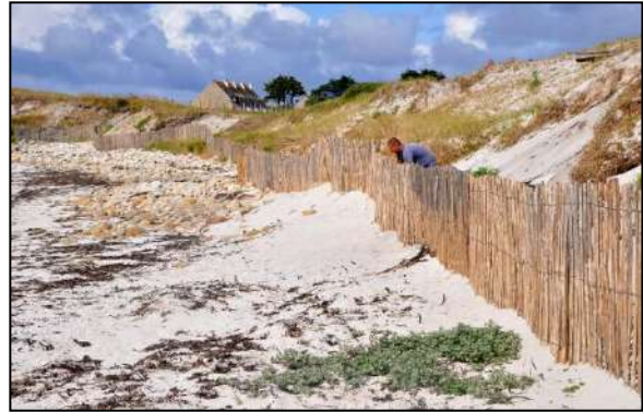
Photo : pose de ganivelle –côte est © BV
