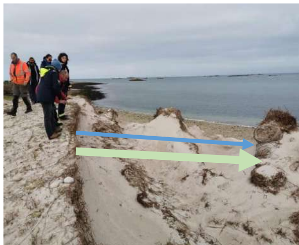
Photos : Stratégie de confortement d'une caoudeyre par positionnement de ganivelles et bottes de foin – Avril 2024
