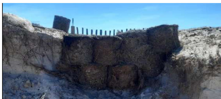
Photos : Stratégie de confortement d'une caoudeyre par positionnement de ganivelles et bottes de foin – Avril 2024
