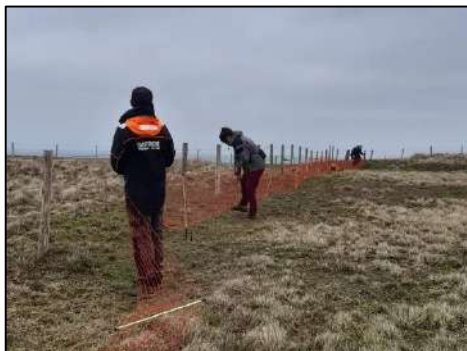
Photo 1 : pose de la clôture électrique autour de la réserve
