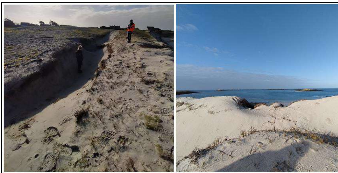
Photo : Dégradation de la Dune nord de Saint Nicolas des Glénan - Suivi géomorphologique - décembre 2023 © G. Hamon
