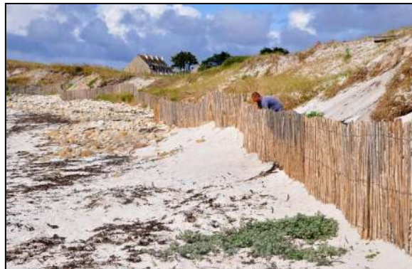
Photo : pose de ganivelle –côte est © BV
