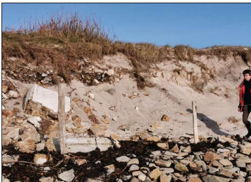
Photo : Mise à nu de la décharge après le passage de la tempête Ciaran @ M. Diard BV 2023
