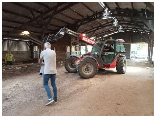
Installation des barrières et des cornadis
