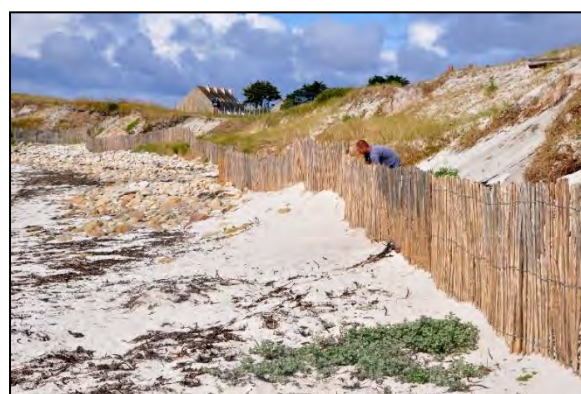
Photo : pose de ganivelle –côte est © Bretagne vivante
