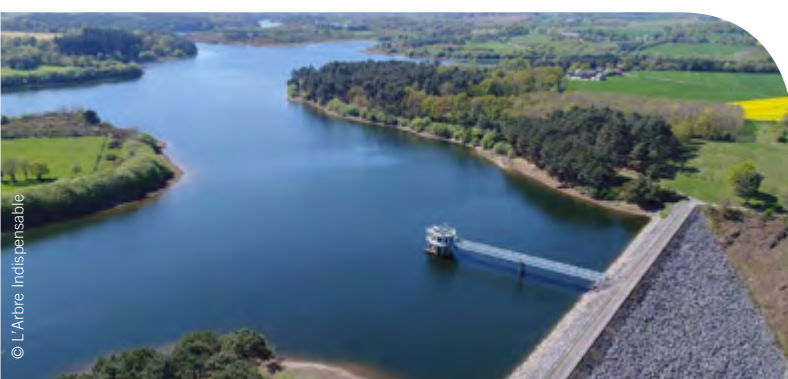
Barrage de la Chèze
