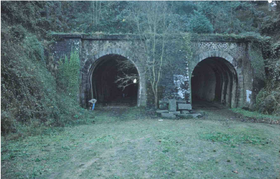
Figure 4 : Site 2. Vue du double tunnel ferroviaire.
